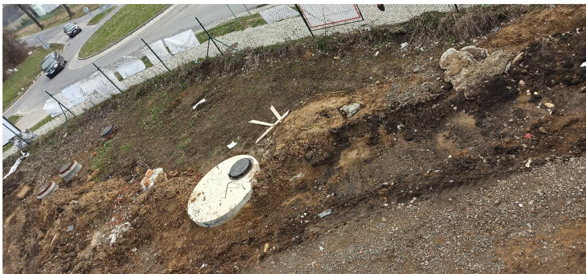
Vsakovacia studňa – miesto pre uloženie akumuláčnych nádrží
