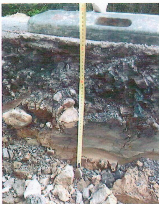
Obr. 6 Konštrukcia pôvodnej vozovky
